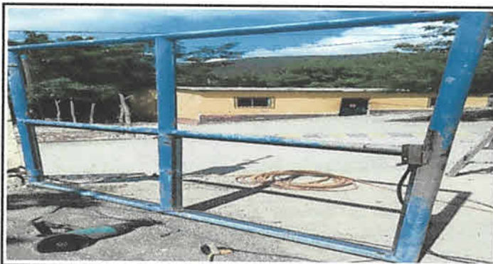
Foto 5: Reparación de Portón
