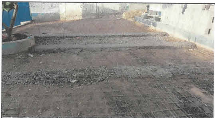
Foto 3: Losa de Cemento en patio
