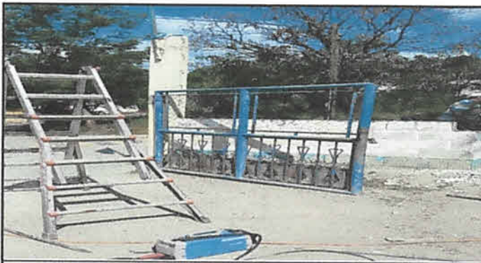
Foto 6: Reparación de Portón
