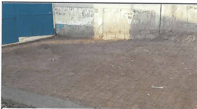
Foto 4: losa de cemento en patio
