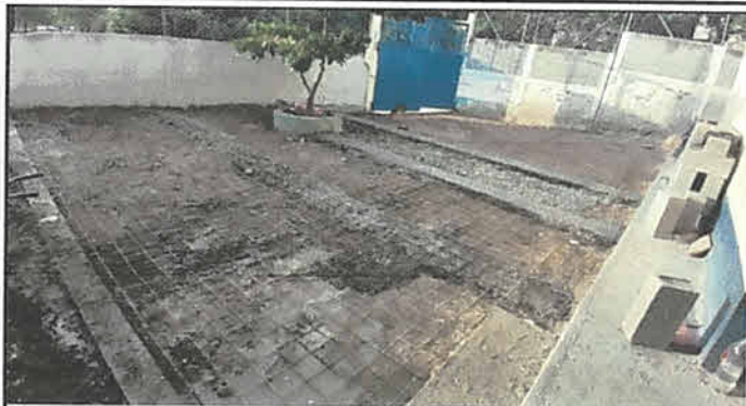
Foto 2: Fundición de Losa de cemento en patio
