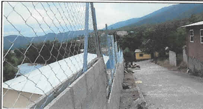
Foto1: Instalación de malla
